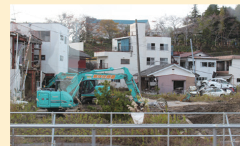
建物撤去作業
